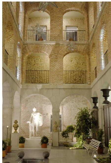
Para poder proceder a la restitución posterior de los muros dañados, se conservaron mamposterías y ladrillos originales de las demoliciones realizadas, y posteriormente se realizaron con estos materiales reparaciones y nuevos muros.
